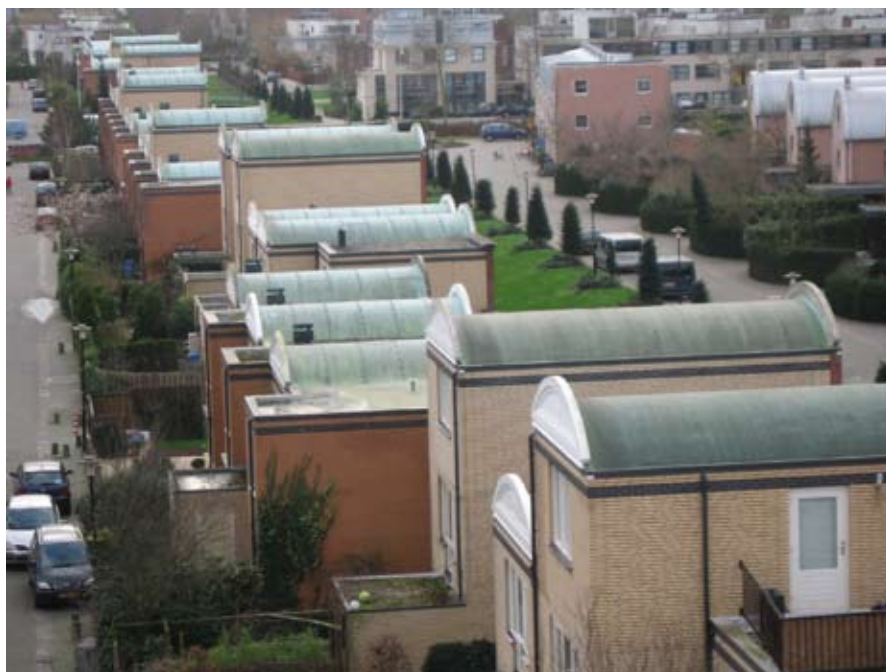
des surfaces de toiture claires polluées
